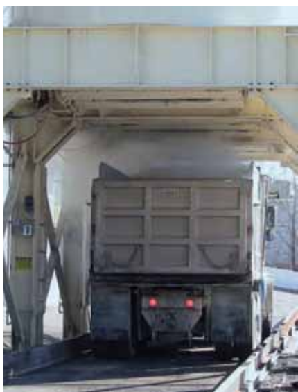
Высыпка бункера: футеровка бункера плитами Matrox® обеспечивает равномерную и непрерывную отгрузку сыпучего материала
