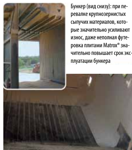
Футеровка бункера методом приварных шпилек с резьбой: хорошо заметно расположение крепежных точек
